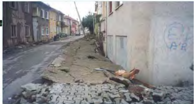
Liquefazione e cedimenti permanenti
