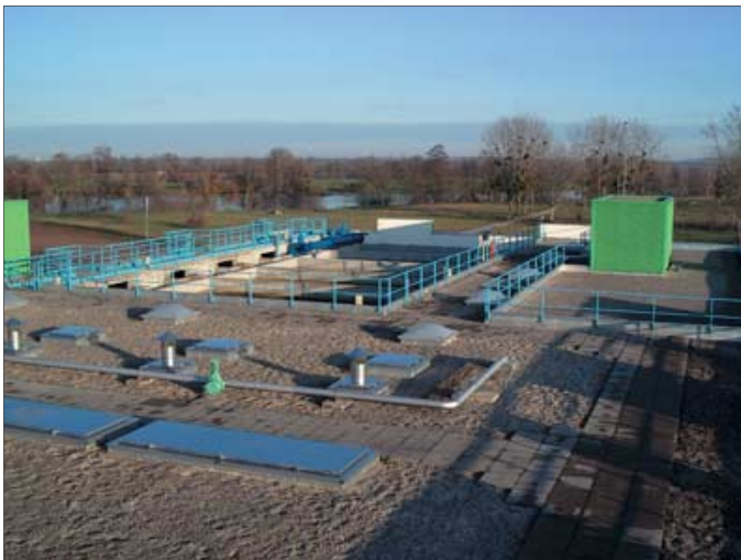
Photo 1 Accès en toiture au filtre à sable et à charbon.
