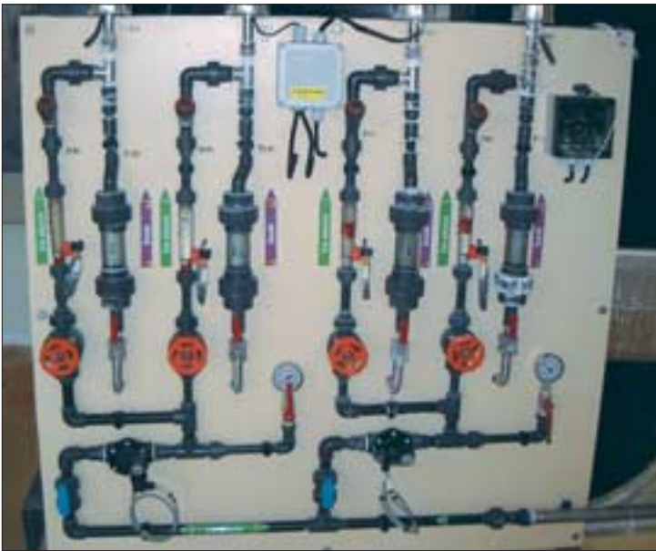
Photo 4 Tuyauteries soude/eau adoucie avec signalisation indiquant la nature et le sens des fluides.
