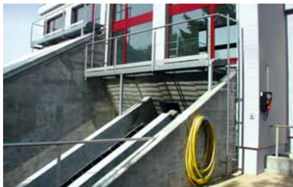
Figura 41 Questa passerella permette agli addetti di pulire le finestre o spruzzare acqua sulla pompa a coclea senza correre rischi.
