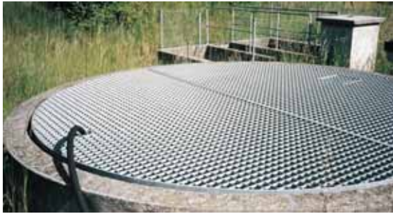
Figura 17 Griglie e coperchi devono essere fabbricati con materiali resistenti, come acciaio o materiale sintetico.
