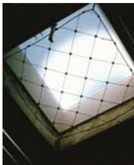
Figura 27 Lucernario protetto da una rete
