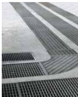
Figura 13 Canali di raccordo coperti da griglie metalliche. Il passaggio è sgombro.
