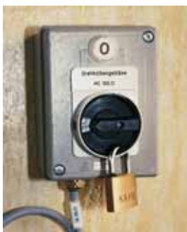
Figura 6 Interruttore di sicurezza con LED integrato ■ chiudibile con lucchetto individuale in posizione disinserita
