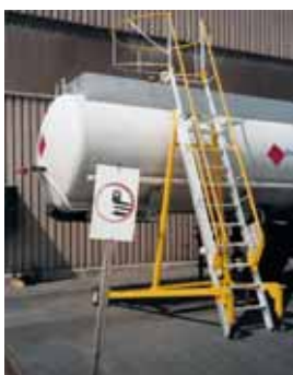
Figura 46 La scala mobile consente di salire sull'autocisterna in condizioni di sicurezza.
