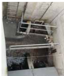
Figura 42 La passerella con parapetto permette di lavorare senza correre rischi. Un operatore può compartimentare le singole vasche stando in piedi sulla passerella, senza alcun pericolo.
