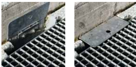
Figure 29 e 30 La cavità inutilizzata della griglia può essere chiusa con un coperchio.
