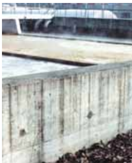
Figura 18 L'altezza del muretto perimetrale è di 110 cm sul livello del terreno.
