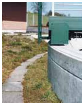
Figura 19 In seguito all'abbassamento del terreno il preesistente muretto perimetrale del bacino funge da protezione anticaduta dell'altezza di 110 cm.
