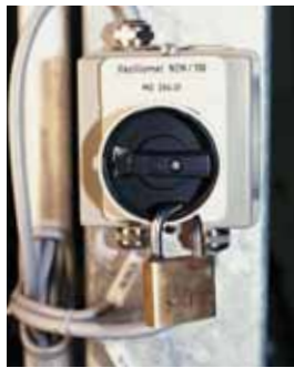
Figura 4 Interruttore di sicurezza ■ indicazione delle posizioni dell'interruttore ■ colore distintivo, ad esempio grigio o nero ■ interruttore chiudibile con lucchetto in posizione disinserita
