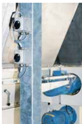
Figura 2 Se l'interruttore di sicurezza è posizionato all'interno dell'impianto, è possibile mettere in sicurezza l'impianto prima di introdurre le mani (misura comportamentale).
