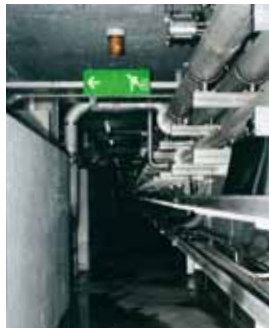
Figura 49 Segnalazione corretta della via di fuga
