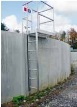
Figura 25 Pedana di lavoro con protezione anticaduta
