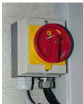
Figura 7 Interruttore di sicurezza combinato con un interruttore di arresto d'emergenza
