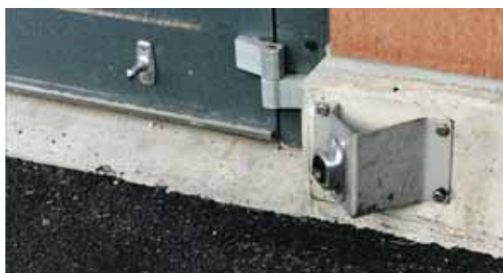
Figura 31 Applicando il fermaporta sulla parete si elimina il pericolo di inciampare.
