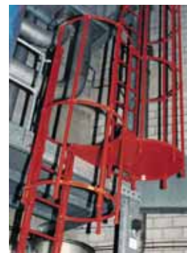
Figura 24 Due scale a pioli fisse collegate da pedane intermedie
