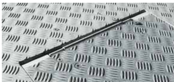
Figura 28 Nelle aree di passaggio le cerniere devono essere incassate nel pavimento.
