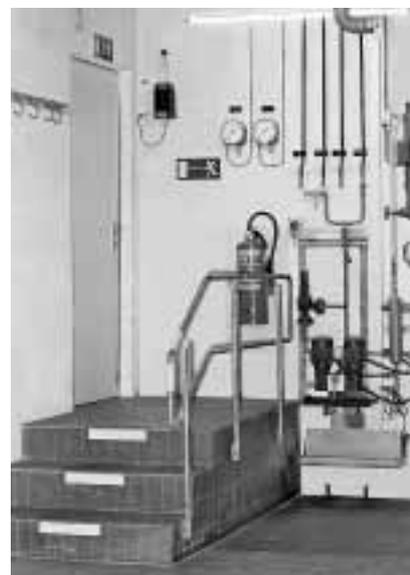
Figura 4: via di fuga segnalata da strisce fotoluminescenti (luce diurna).
