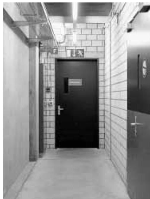
Figura 3: via di fuga delimitata da una porta apribile nel senso dell'esodo.
