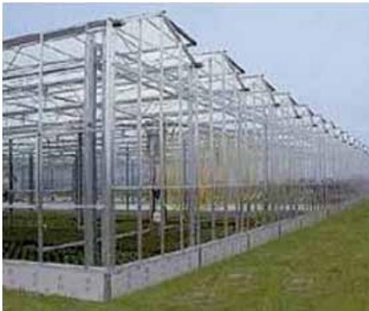
Struttura metallica di serre con rischio di caduta dall'alto in fase di manutenzione
