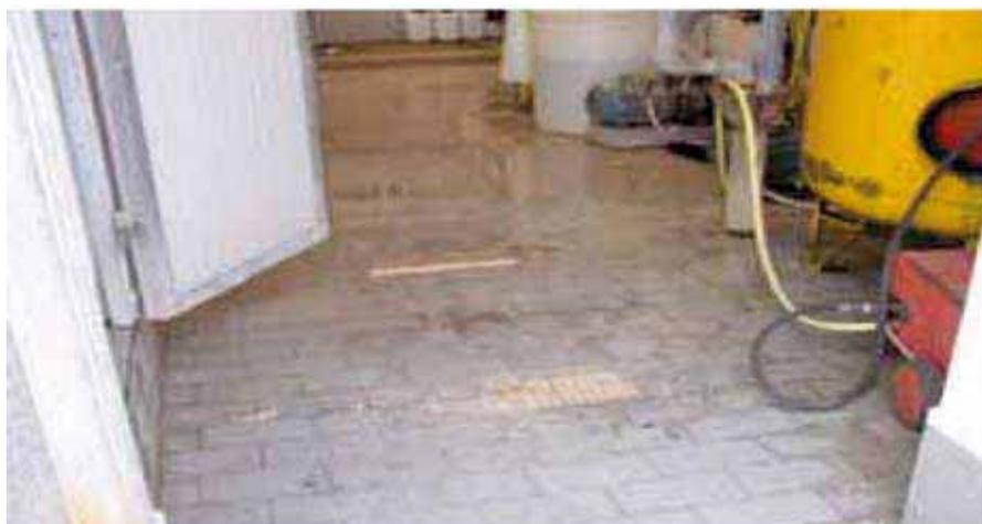
Esempio di superficie scivolosa e sdruciolevole: insufficiente drenaggio con pericolosi ristagni d'acqua.
