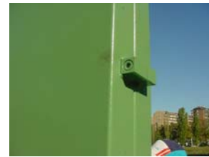
Esempio di apertura carter effettuabile mediante utensile
