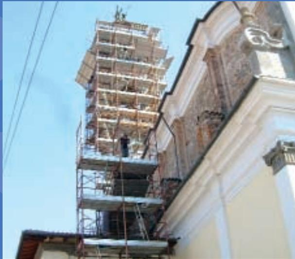
Assicurati sempre che il ponteggio sia stabile, perfettamente in piano, efficacemente ancorato alla costruzione, provvisto di parapetti e di tavole fermapiède su tutti i lati verso il vuoto.
