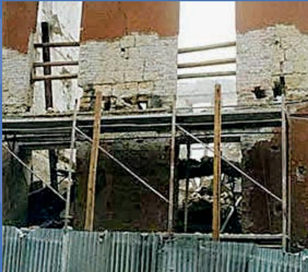
Durante le demolizioni ad altezza superiore a 2 metri utilizzare sempre piani di lavoro stabili ed autoportanti.
