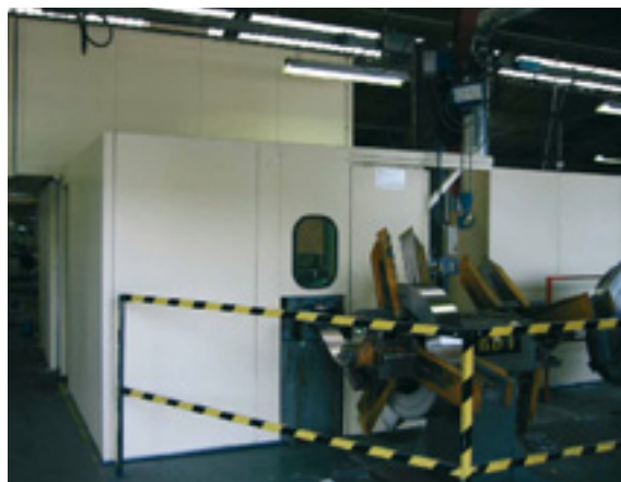
Entrée du feuillard dans l'encoffrement
