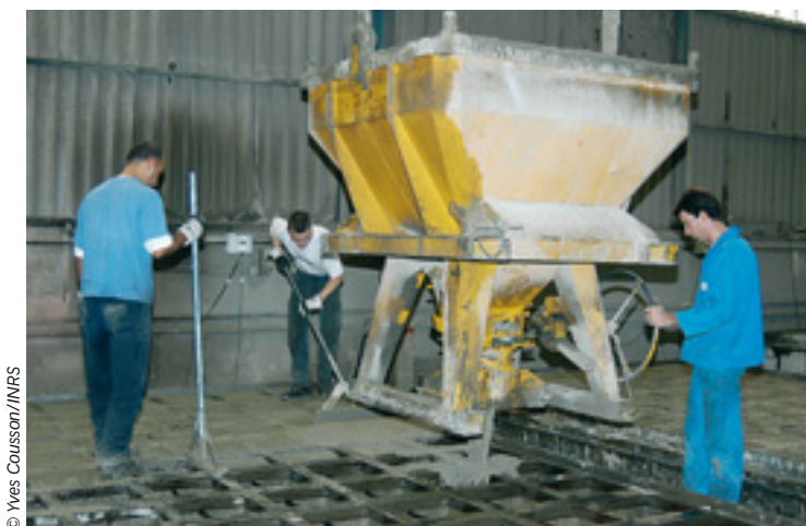
Chargeuse de béton
