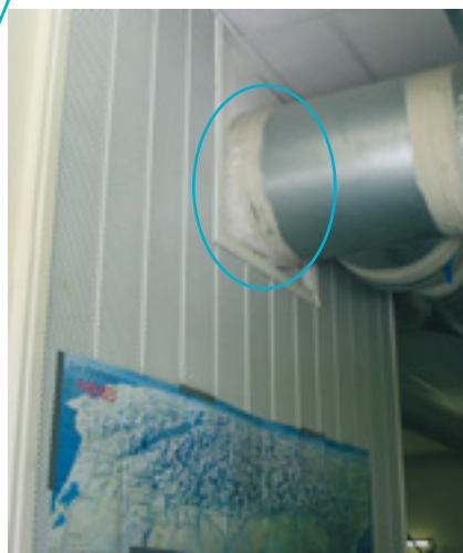
Zoom sur le passage colmaté d'une gaine à travers la cloison acoustique
