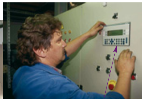
Variateur électronique piloté par un automate programmable
