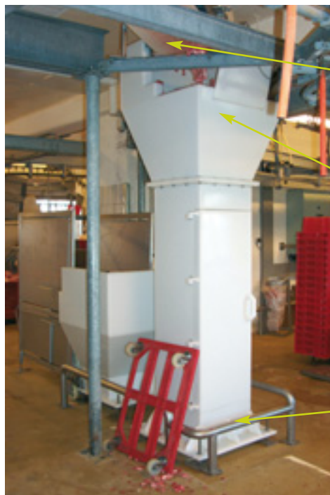
Goulotte en structure sandwich après traitement
