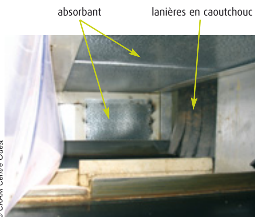
Tunnel acoustique aux entrées-sorties
