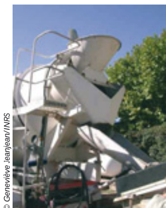
Approvisionnement par camion à béton
