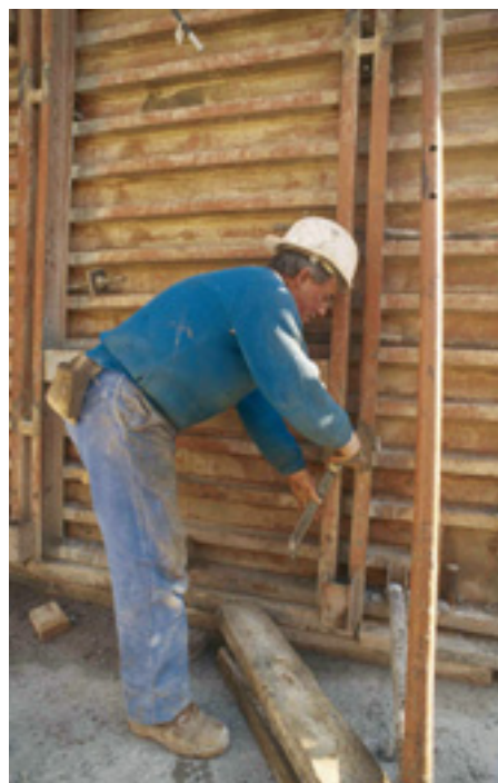
Serrage des banches à la clef
