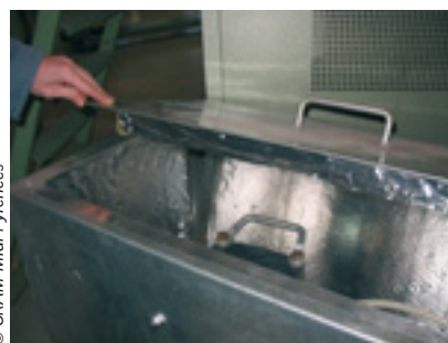
Ouverture de l'encoffrement
