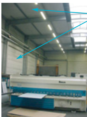
Traitement antiréverbérant du local
