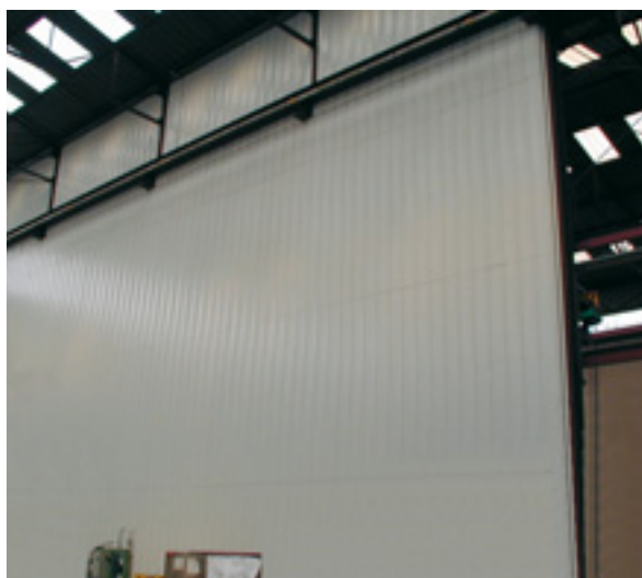
Nouvelle cloison acoustique
