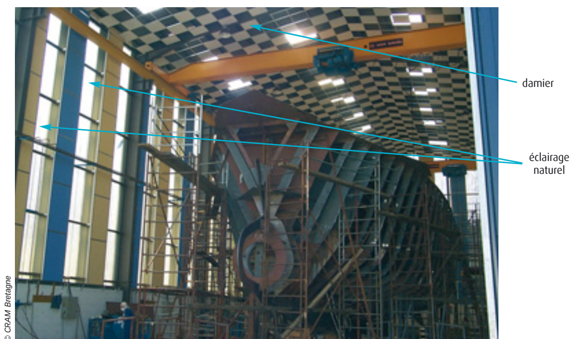
Vue d'ensemble du local traité
