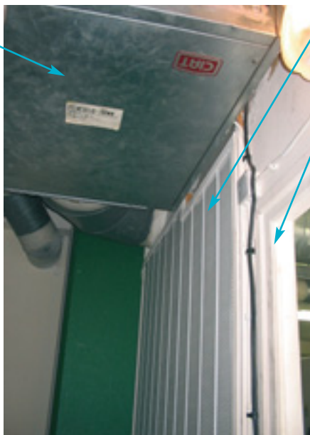
Intérieur du local
