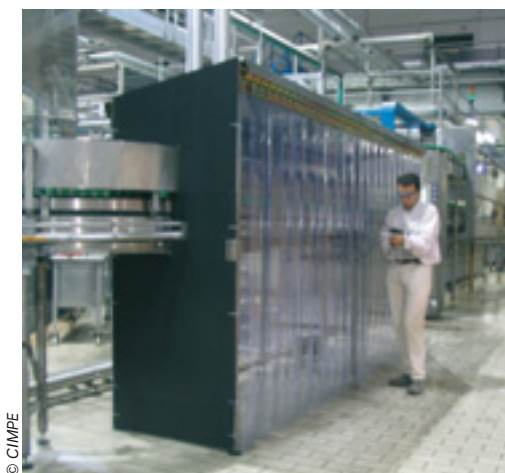
Premier tronçon installé
