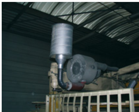
Mise en place du silencieux
