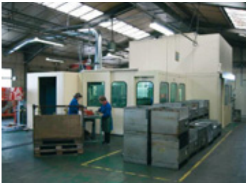
Vue globale de l'encoffrement
