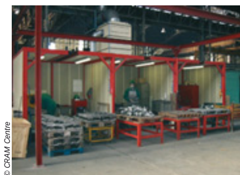
Aménagement des box
