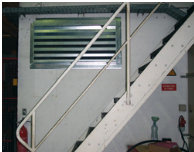
Vue des louvres
