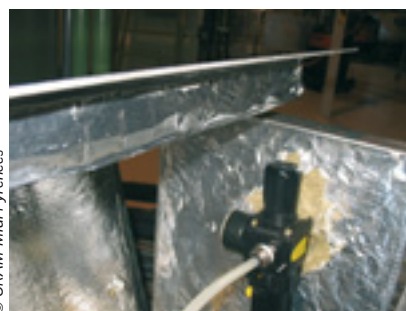
Intérieur de l'encoffrement
