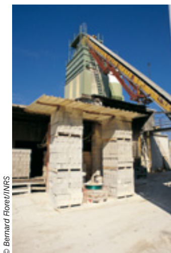
Vue de la centrale
