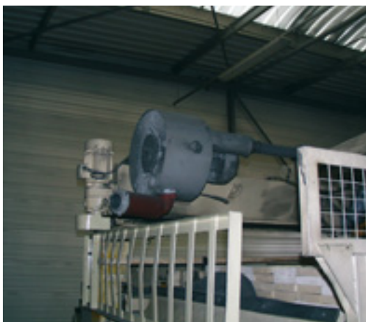
Installation avant modification
