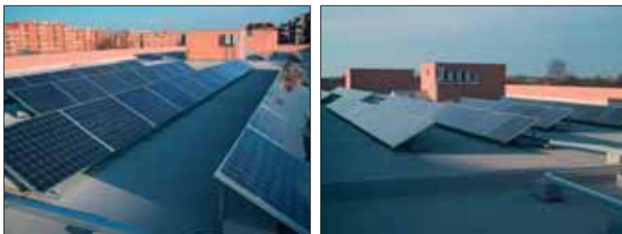
Foto delle stringhe dell'impianto fotovoltaico connesso alla rete, installato sul tetto piano della scuola, con potenza massima di 20,13 kWp
