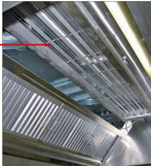
Hotte d'aspiration avec système à lampes UV.
