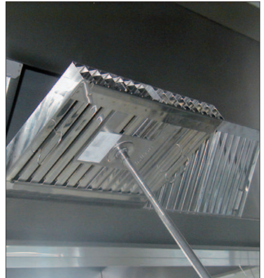
Outil de démontage/remontage du filtre en position.
