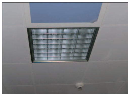
Faux plafond en dalles acoustiques nettoyables avec luminaire et trappe de visite.
