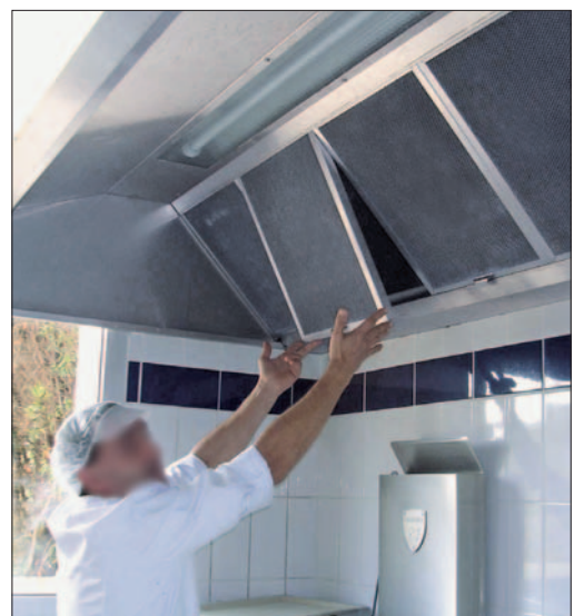
Démontage de plain-pied d'un filtre de hotte.
