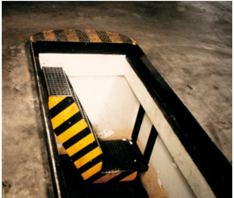
31. Escalier de fosse de visite : les marches sont constituées de caillebotis antidérapants (la disposition de l'escalier dans le sens longitudinal de la fosse permettrait un accès plus aisé dans celle-ci)
