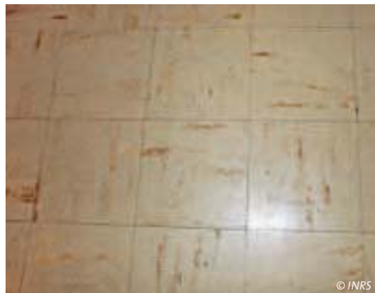
Dalles de sol vinyle amiante
