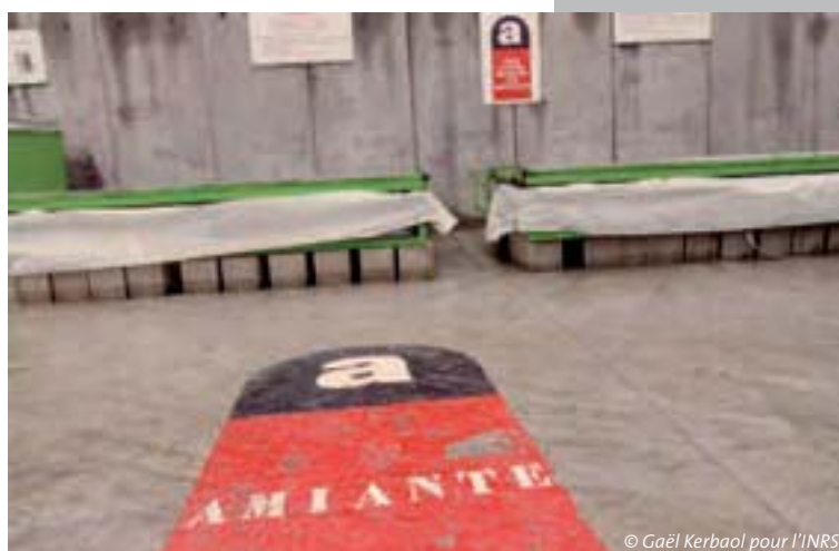
Dépôt bag maintenu dans une structure avec couvercle
