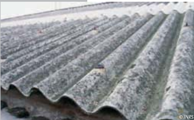
Plaques de toiture en amiante-ciment
