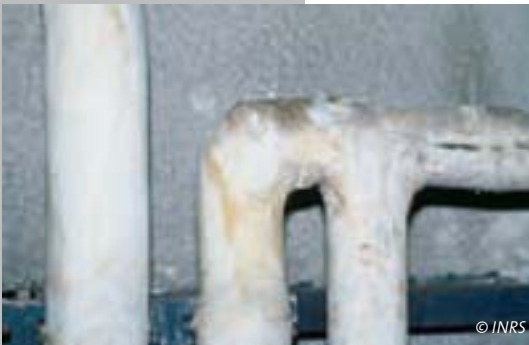
Calorifugeage de canalisations
