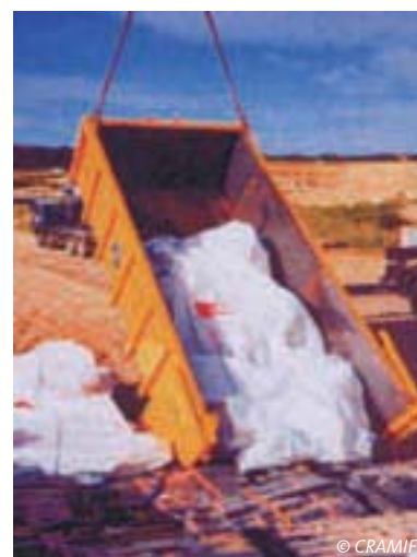
Dépose d'un emballage de la dimension d'une benne dans une alvéole
