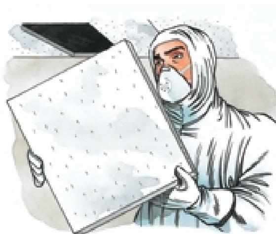
Trattare adeguatamente le lastre prima della rimozione. Operare eliminando i rischi, di caduta o sfondamento delle lastre, con adeguate misure di protezione. La rimozione va eseguita utilizzando attrezzi manuali o a bassa velocità. Le lastre rimosse vanno adeguatamente pallettizzate, avvolte con fogli di polietilene ed i pacchi sigillati ed etichettati. È vietato frantumare le lastre. È vietato gettare le lastre dall'alto.
