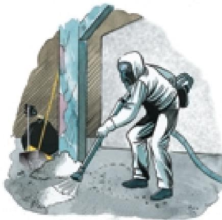
Non frantumare le lastre in cemento-amianto. Trovando dei residui trattarli adeguatamente prima di insaccarli. Aspirare le polveri con aspiratori dotati di filtro assoluto. Ripulire il pavimento "ad umido".
