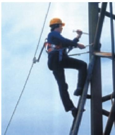
Esempio di sistema anticaduta con uso di imbracatura - fune di sospensione paracadute - fune di trattenuta - ancoraggio
