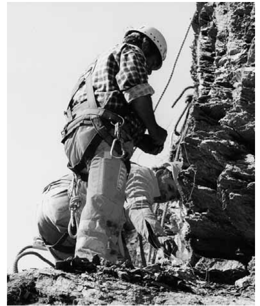
Fig. 3: protezione anticaduta con imbracatura e funi di sicurezza.
