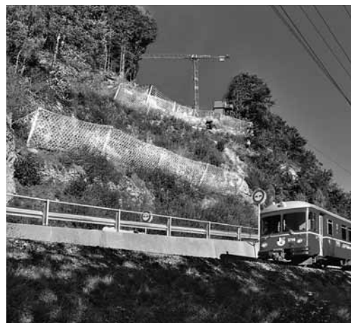
Fig. 2: quando si procede alla messa in sicurezza delle vie di circolazione pubbliche o delle condutture di alimentazione bisogna attenersi alle disposizioni dei proprietari.
