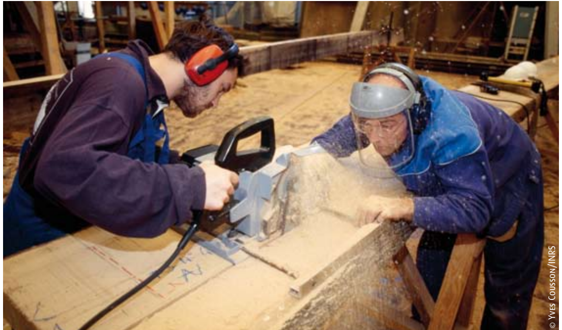
La prévention passe par une intervention sur les conditions de travail dès la mise en place des procédés : elle peut être réalisée lors de travaux de rénovation ou de changements de matériels.
