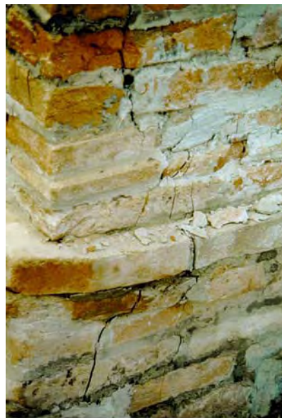
Figura 2.11 Muratura di mattoni pieni
