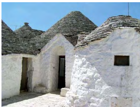
Figura 2.10 I trulli, esempio di costruzione in pietra
