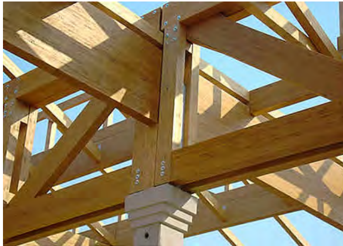
Figura 2.7 Travi in legno lamellare
