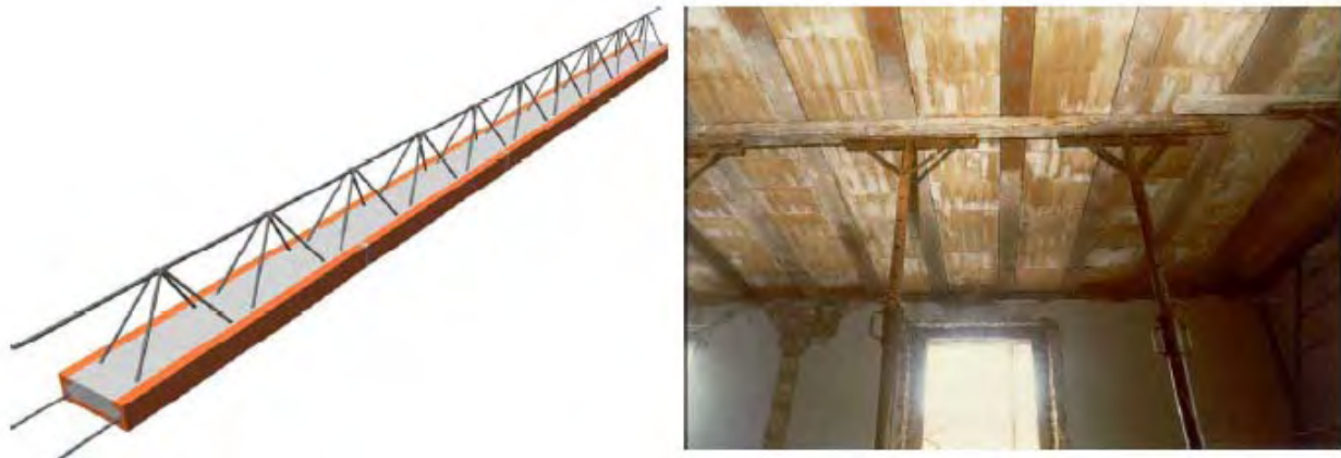
Figura 10.9 – Solai in c.a. con travetti intralacciati
