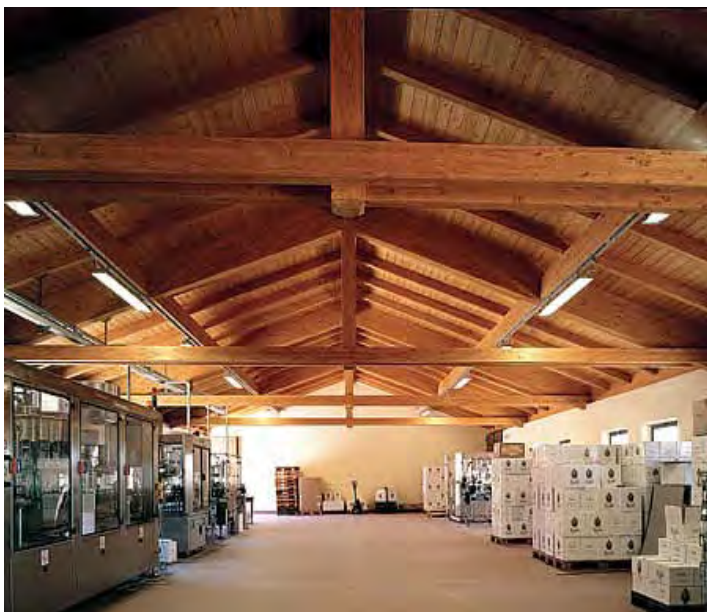
Figura 2.1 Esempio di capriata in legno
