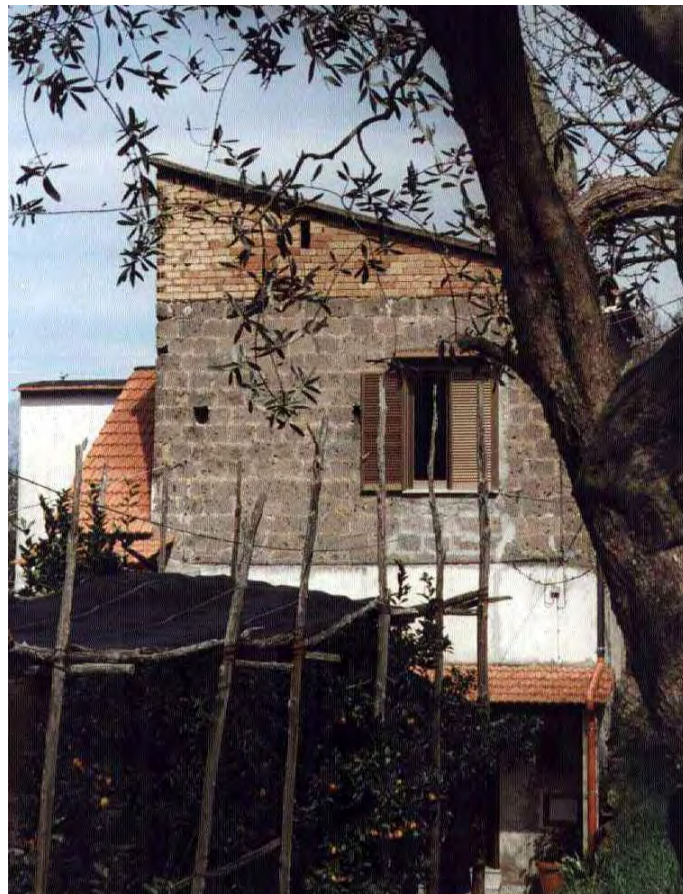
Figura 7.1 - Esempio di fabbricato sopraelevato
