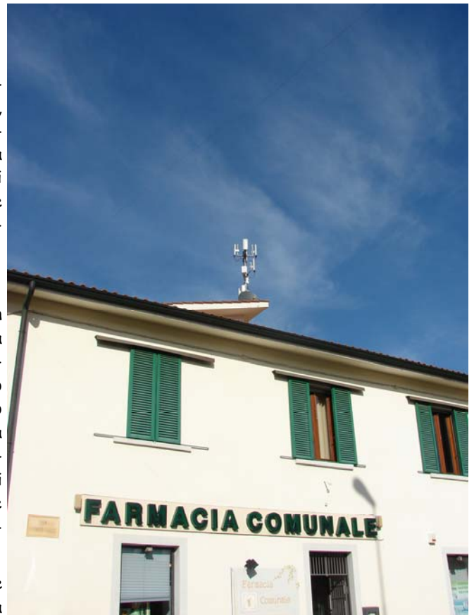
sito che serve all'operatore a distribuire il segnale verso (e da) più utenti.
