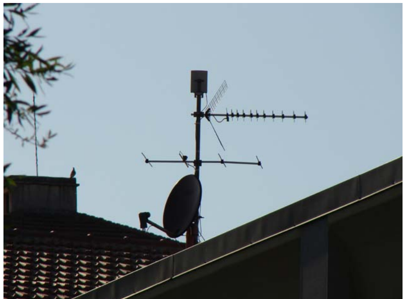
classica antenna "palina" utilizzata dall'utente per collegarsi in rete (in questo caso è stata installata sullo stesso palo dell'antenna TV)
